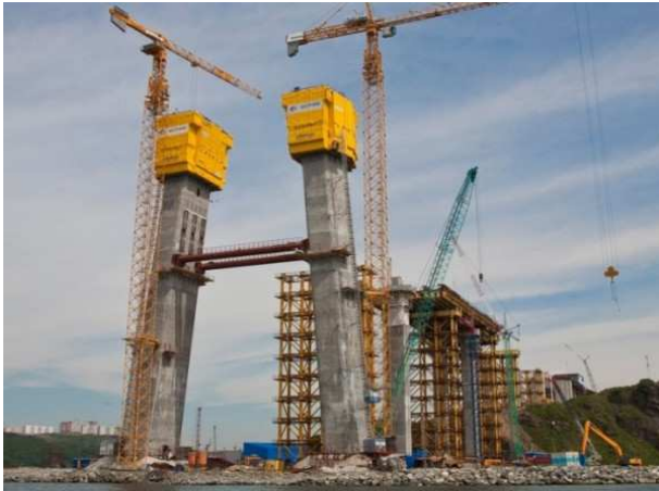
Рисунок 2 – Применение высокопрочного бетона при строительстве пилон вантавого моста на остров Русский
