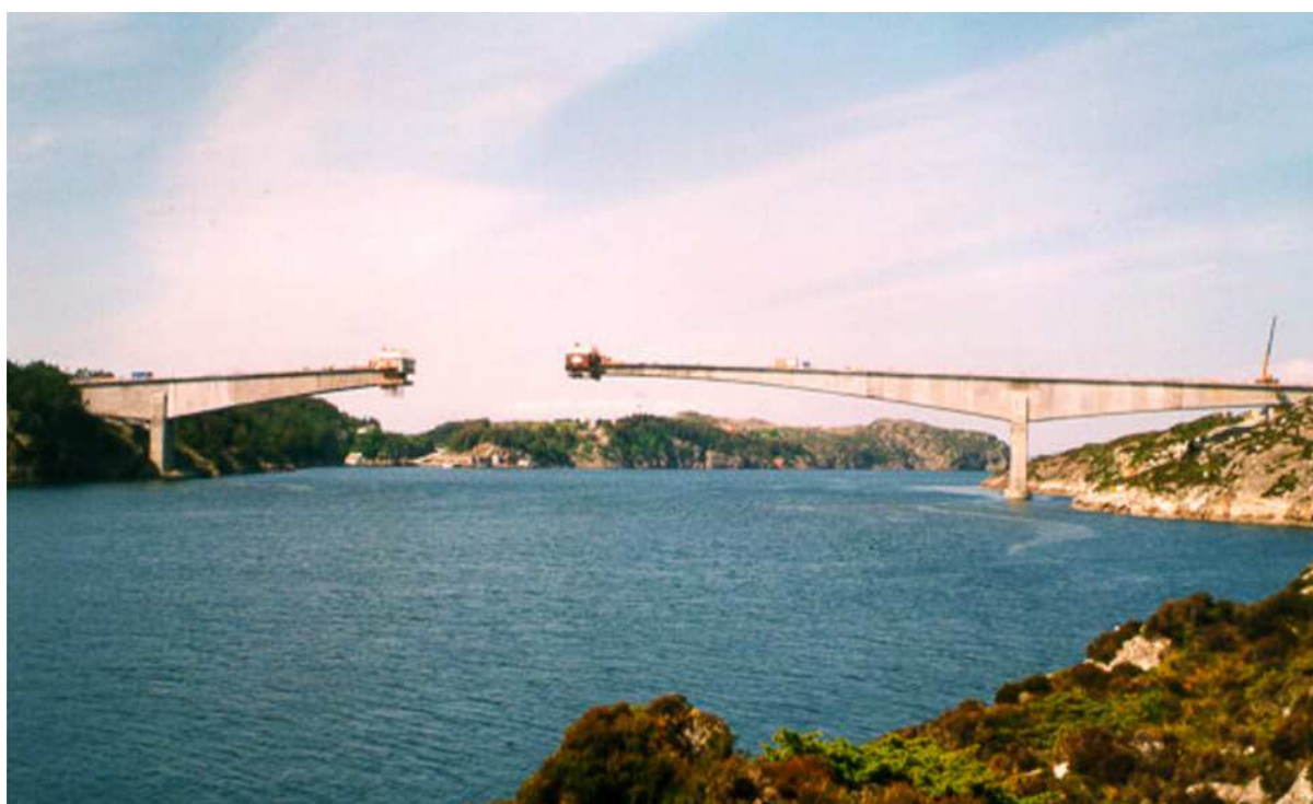
Рисунок 4 – Мост «Stolma bridge» в Норвегии, построенный из высокопрочного лёгкого бетона
