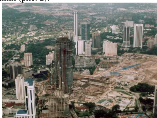
Рис. 2. Строительство башен Петронас в Куала-Лумпур из высокопрочного бетона
