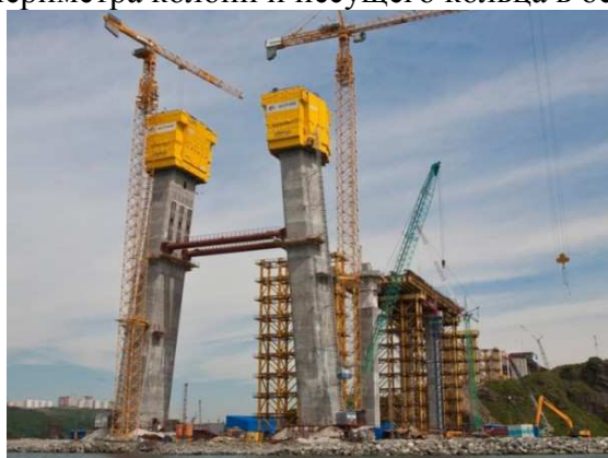
Рис. 1. Применение высокопрочного бетона при строительстве пилон вантового моста на остров Русский
