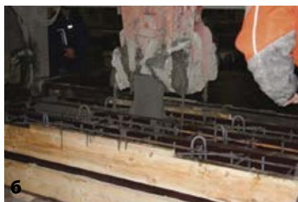
Рис. 3. Фотографии процесса изготовления изделий из высокопрочного легкого бетона (а — опалубка и арматурный каркас, б — формирование изделия)
