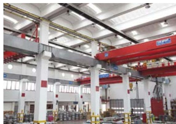
Возможность полносборной комплектации из сборного ЖБИ любого здания по индивидуальному проекту, включая систему фундамент-колонна-балка (ригель) — элементы перекрытия (покрытия) — стеновое ограждение, лестнично-лифтовой блок
