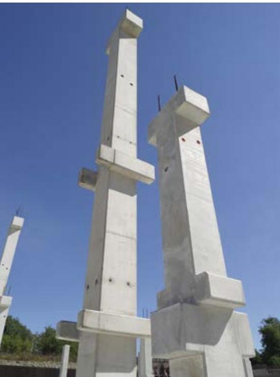
Изготовление многоярусных колонн длиной до 28 м возможно любого сечения
