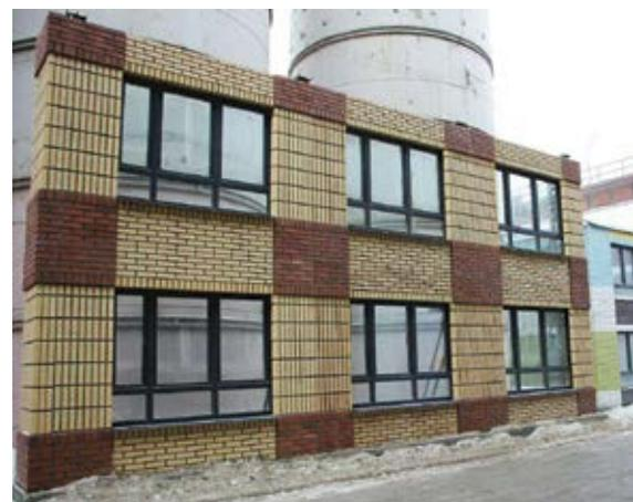
На предприятиях группы изготавливают фасадные панели с полной финишной обработкой поверхности
