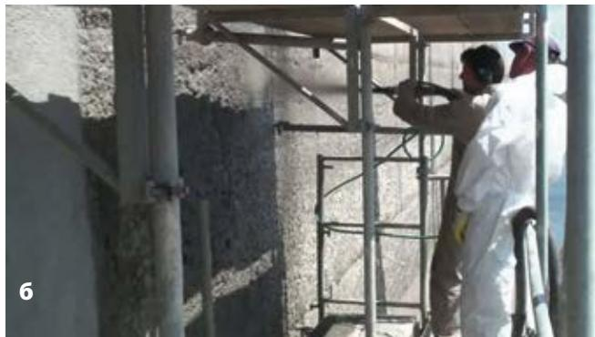
**Рис. 7.** а) Состояние верхнего резервуара насосной гидростанции (Hohenwarte II, Тюрингия, ФРГ) до ремонта, б) Торкретирование высокопластичного композита (содержащего SAP) на основе цемента в качестве материала для ремонта.
